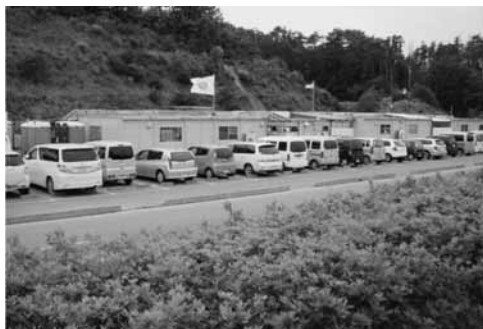
写真20：イスラエルの医師団が造った仮設の病院をそのまま使用（公立志津川病院）
