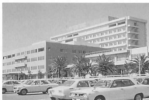
完成した病院棟と研究棟
